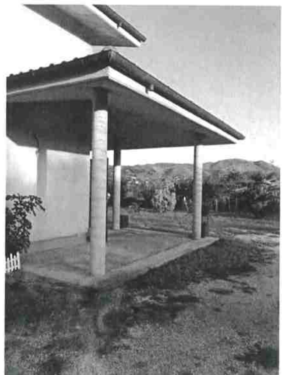
PORTICO VISTA LATO SUD-OVEST
