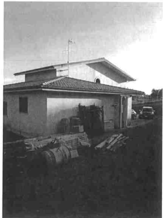
VISTA FRONTE NORD-EST
