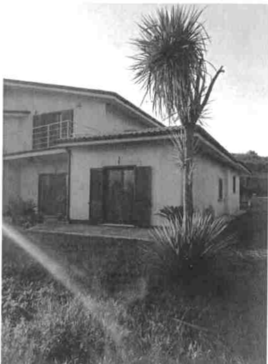
VISTA FRONTE SUD EST
